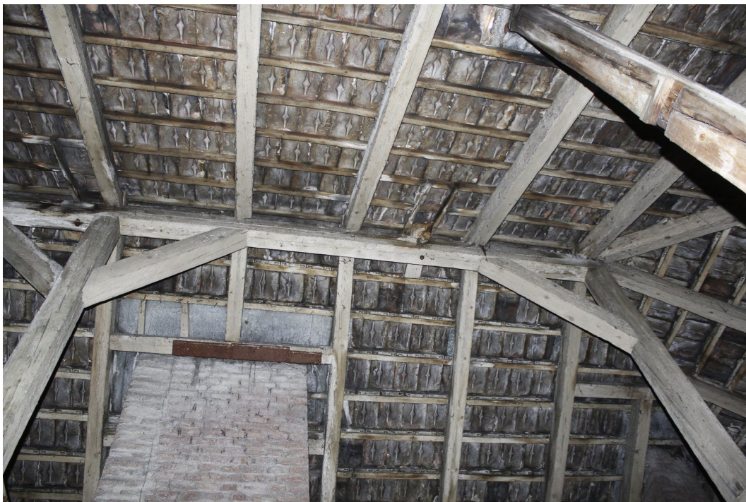
3. Střední část budovy. Hřebenová část krovu se stopami zatékání do vrcholové vaznice.
