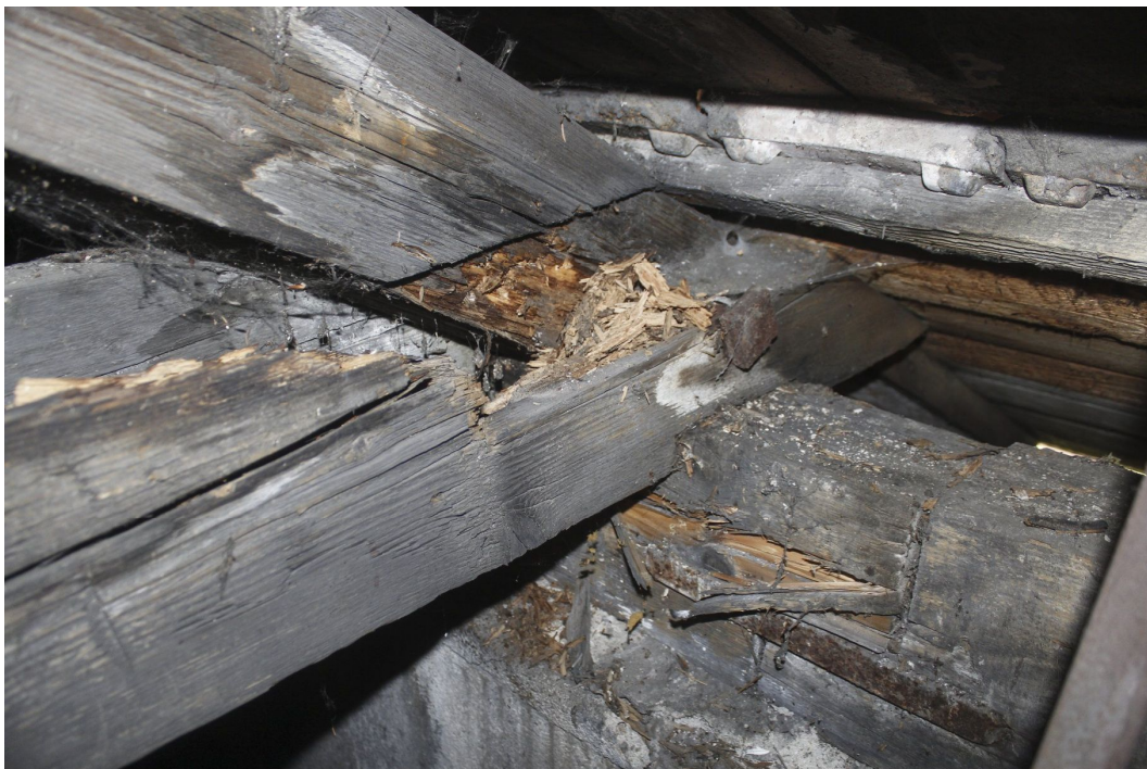
9. Střední část budovy. Poškození kleštin a krokve ligninovorní houbou na jižním průčelí.
