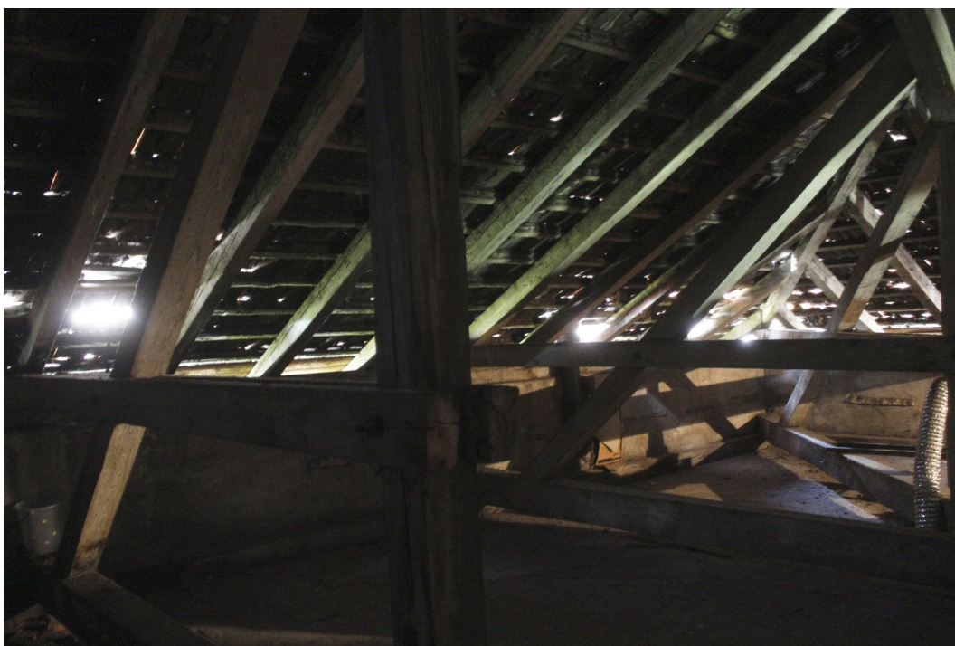
4. Střední část budovy. Značné netěsnosti taškové krytiny způsobující drobné zatékání na mnoha místech půdorysu.
