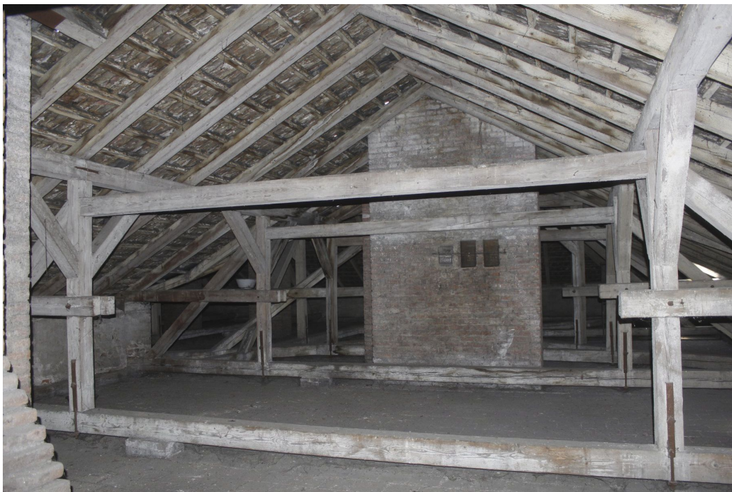
11. Západní část budovy. Konstrukce krovu s dvojitým věšadlem v plných vazbách.
