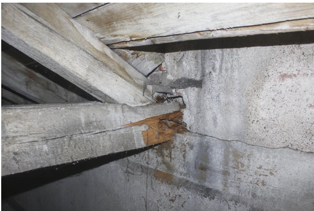
8. Střední část budovy. Silné a rozsáhlé ohnisko dřevomorky domácí podél zaatikového žlabu na severním průčelí. Poškození obou kleštin, krokve a pozednice.
