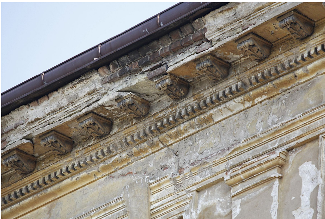
2. Těžké poškození korunní římsy vlivem zatékání okapní částí střechy. Akutní nebezpečí pádu omítky nebo štukových odlišk (konzolek) na chodník podél budovy.
