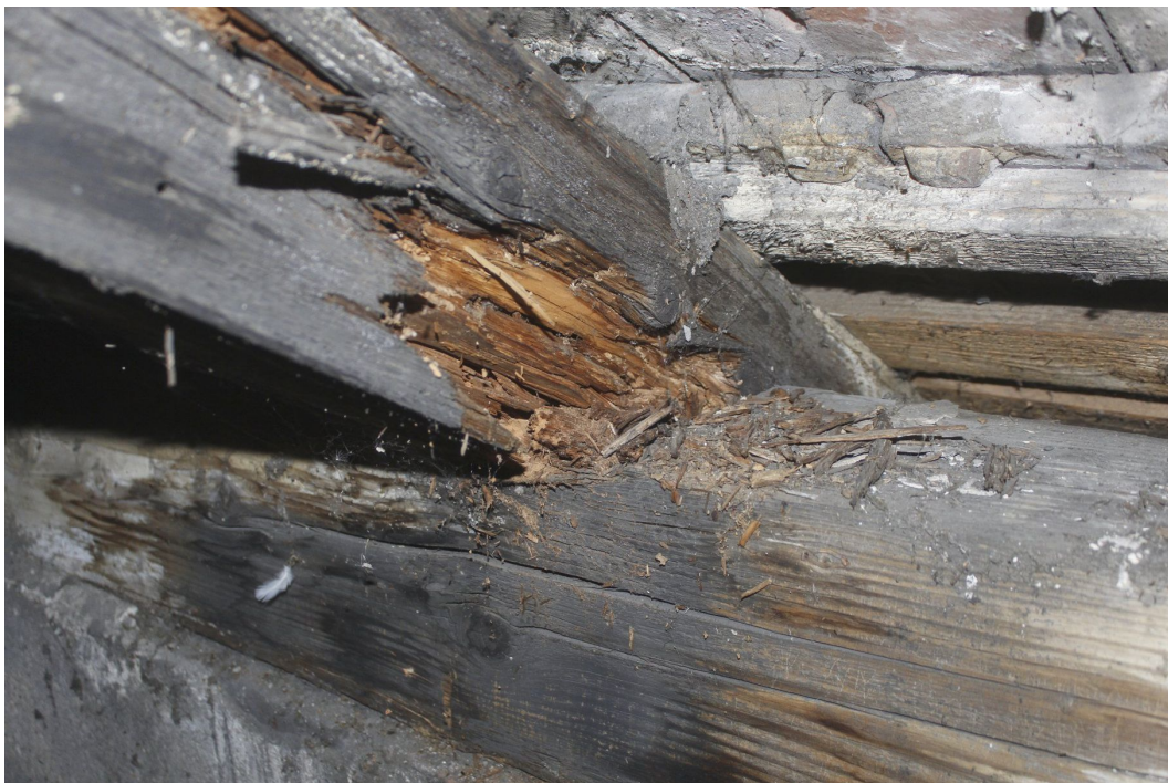
13. Východní část budovy. Krokev a pozednice značně poškozená outkovkou zprohýbanou.
