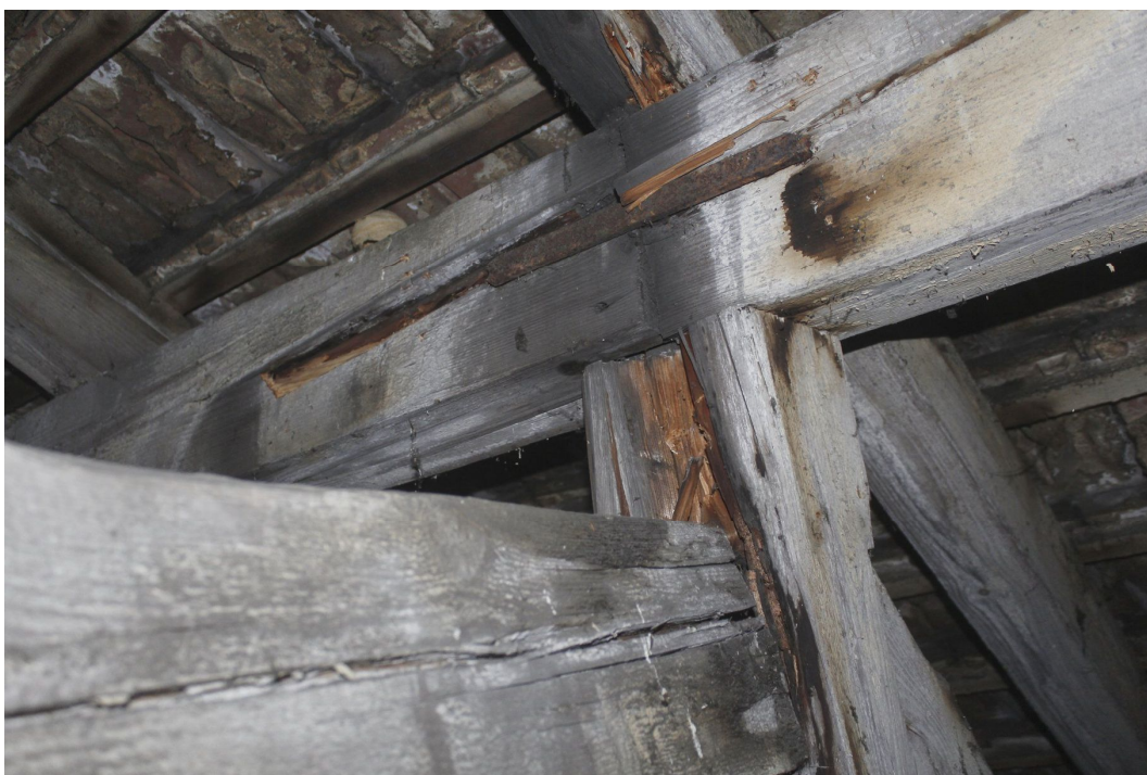
12. Západní část budovy. Plná vazba, těžce poškozená trámovkou.
