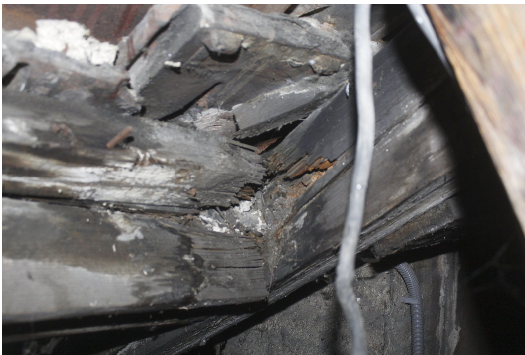
10. Střední část budov. Těžké poškození krokve a komínové výměny trámek.
