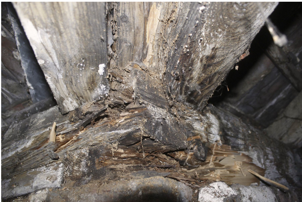
15. Východní část budovy. Úžlabní část, značně poškozená konioforou sklepní. Detail nároží pozednice.
