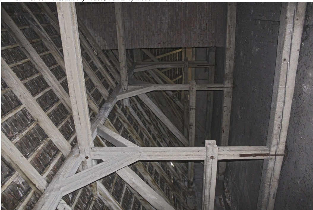
5. Střední část budovy. Část plné vazby u střední vaznice.
