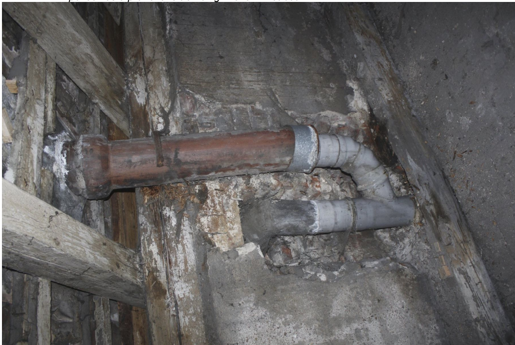
6. Střední část budovy. Zatékání kolem vnitřního zaústění dešťových svodů na jižním průčelí s napadením pozednice a prahového trámu ligninovou houbou.
