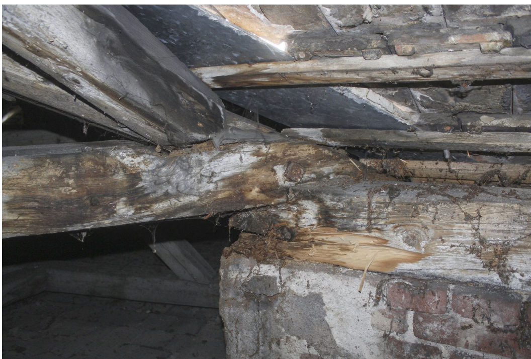
14. Východní část budovy. Úžlabní část, značně poškozená konioforou sklepní.
