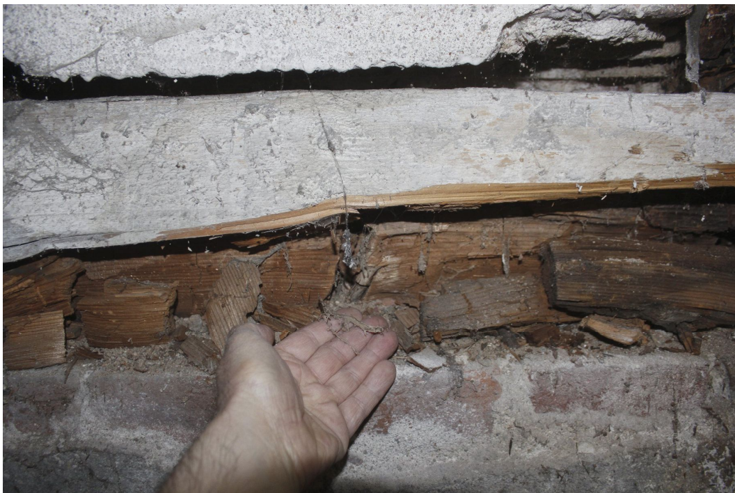
7. Střední část budovy. Silné a rozsáhlé ohnisko dřevomorky domácí podél zaatikového žlabu na severním průčelí. Poškozeny jsou pozednice, konce krokví, zhlaví vazných trámů a kleštiny.
